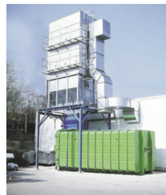
/ Der Filter reinigt sich vollautomatisch: differenzdruck- oder zeitabhängig.
