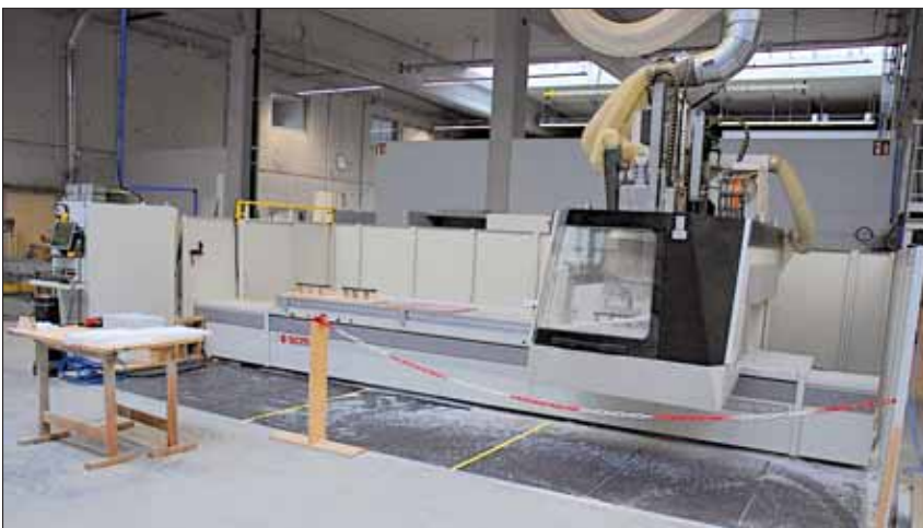
Die Bearbeitungszentren haben einen hohen Absaugleistungsbedarf, liefern aber gleichzeitig auch ausreichend Brennstoff für den Familienbetrieb
