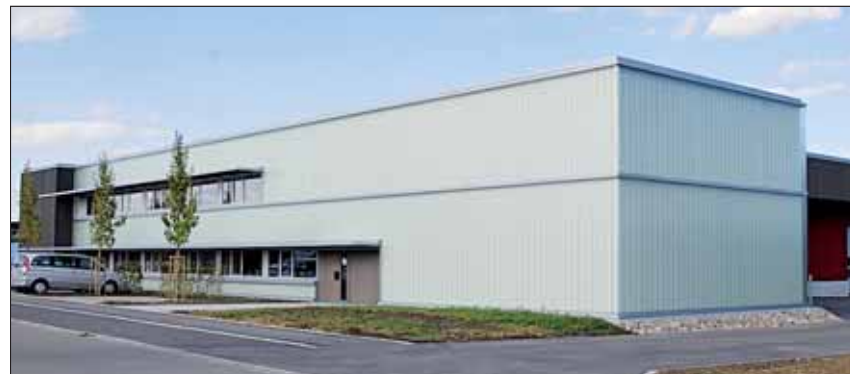
Der Neubau entstand am Ortsrand von Gomaringen in einem Gewerbegebiet
