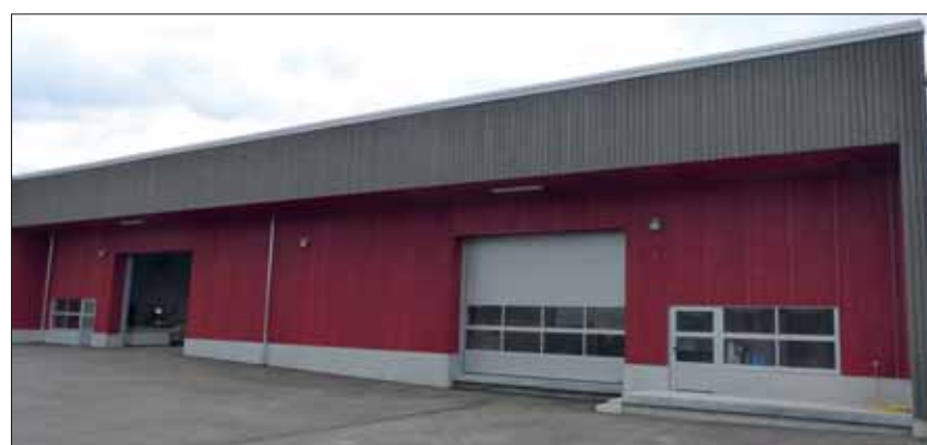
Produktionsbereich des Neubaus, rechts Einfahrt zum Plattenlager, links das Tor vom Versand
