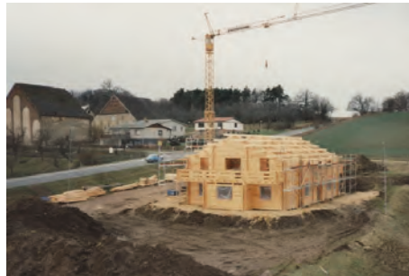
Rohbau des Gästehauses
