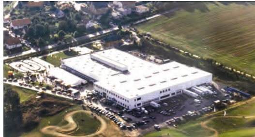
Einweihung des 2. Bauabschnitts, Hainchen, 1998
