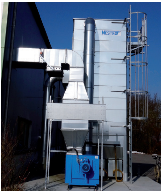
Der Jet-Filter »NSJ 9/5-38« von Nestro arbeitet mit einer Gesamtluftmenge von 10.300 Kubikmetern pro Stunde.
