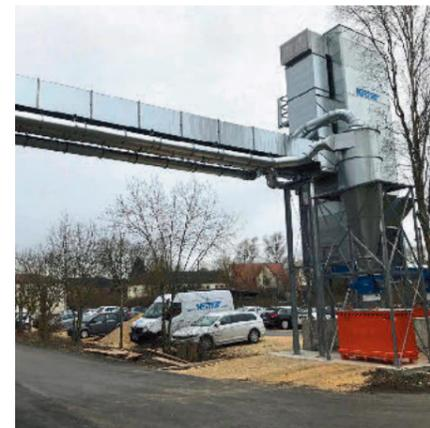
Erweiterbar geplant: Der 2-Elemente-Zwischenfilter NSJ 9/5-33 mit Zyklon-Vorabscheider NZ3 vor sechs Jahren.
