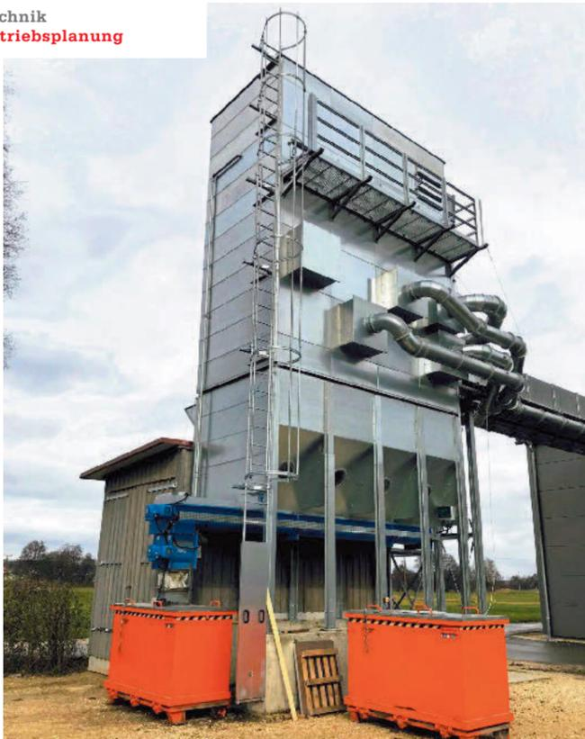
Stand heute ist bei Holzbearbeitung Kraus ein 4-Elemente-Zwischenfilter vom Typ NSJ 9/5-33 mit einem angebauten Gebäude für die Brikettierung im Einsatz.
