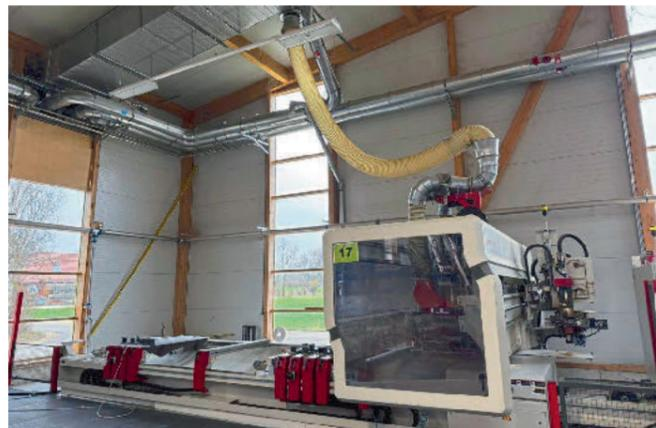
Die Maschinenabsaugung der CNC erfolgt über ein Drehrohr, während die Rückluft über einen Lochblechkanal zurückgeführt wird.
